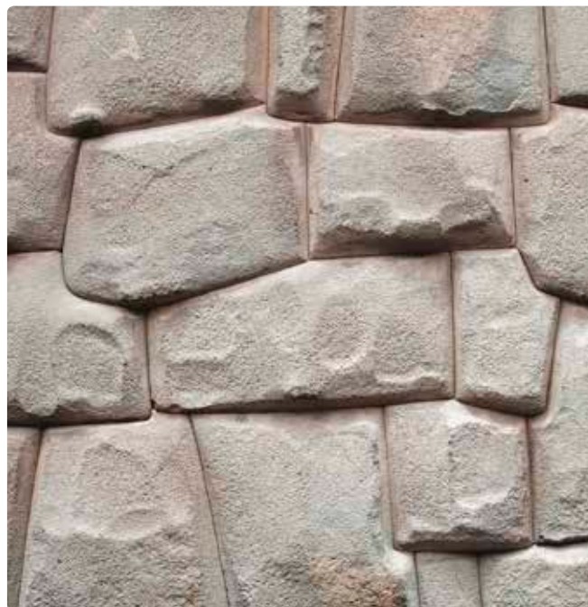
U gradu Cuscu (Peru) nalaze se neki od najfascinantnijih kamenih zidova na svijetu. Ovi masivni megalitski zidovi poznati su po izuzetno preciznoj tehnici gradnje, gdje se kamenje klesalo i slagalo bez ikakvog vezivnog materijala.
